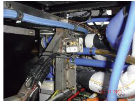
Einbau im Motorraum.
